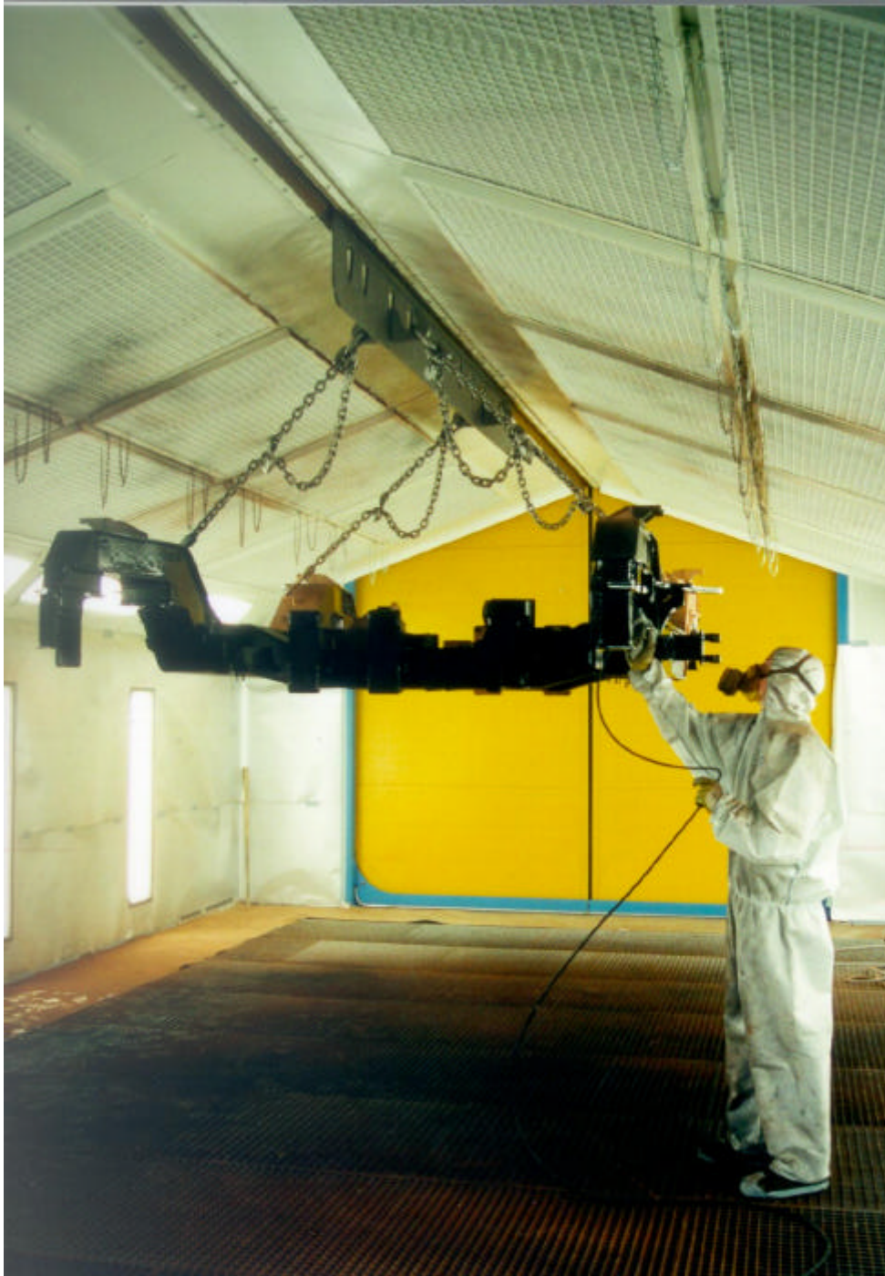
Lackieranlage für Schienenfahrzeug-Drehgestelle, Mit Werkstück-Hub- und Senkstation (oberste Stellung)
