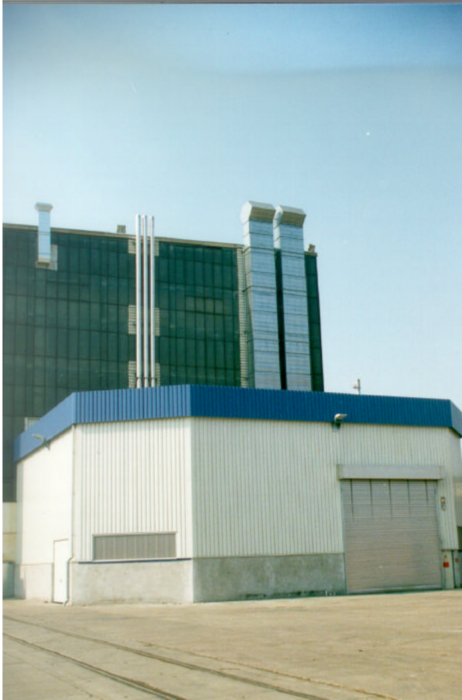
Einhausung für Strahlanlage und Lackieranlage für Windkraft-Türme
